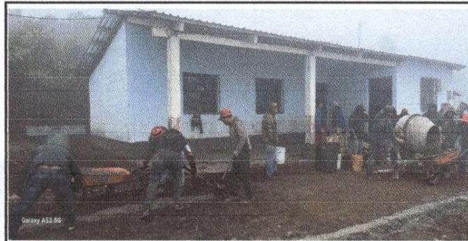
Foto 3: Sustitución de torta de cemento
